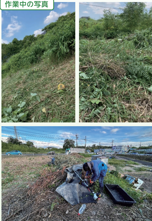
作業中の写真
