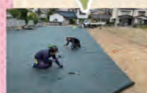
シート敷き込み (固定)
